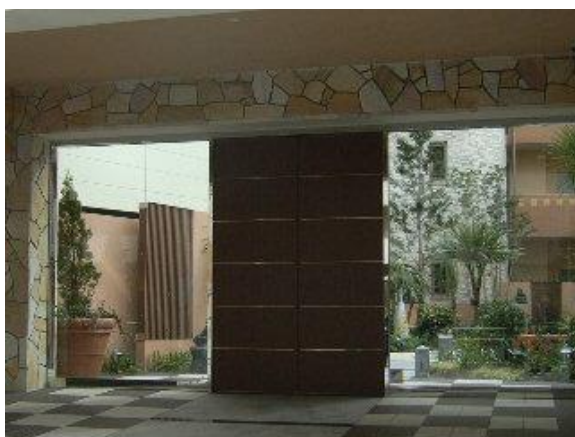
【×：開口部が無く見通せない扉の例】
