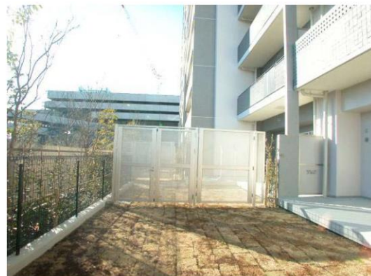
【写真：専用庭のフェンス】
