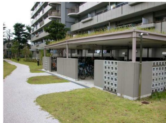
【写真：開放性の高い屋外駐輪場の例】
