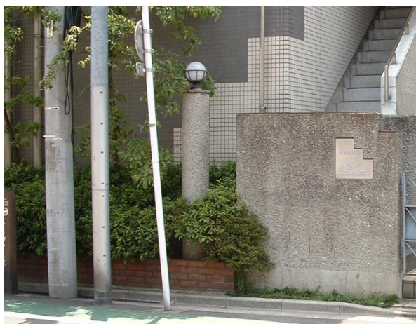
【写真：共用階段に侵入し易い例】
